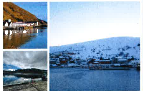
NTP: Kjøllefjord nye havnehamn er inne i NTP, med Skarsvåg og Havøysund er i første posten.
